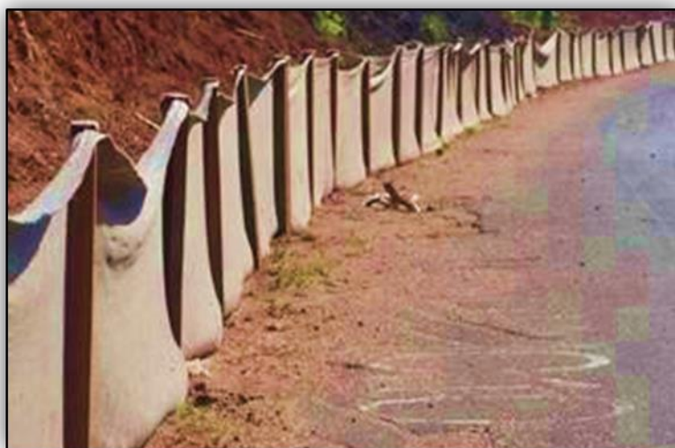
Figura 24 - Exemplo de isolamento com manta geotêxtil.
